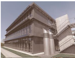
Fertiges Gebäude vor Bezug mit Außenluft-Ansaugtürmen
